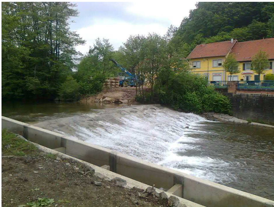
Seuil sur la Doller à Lauw avec passe à poissons fonctionnelle (Photo CD68)
