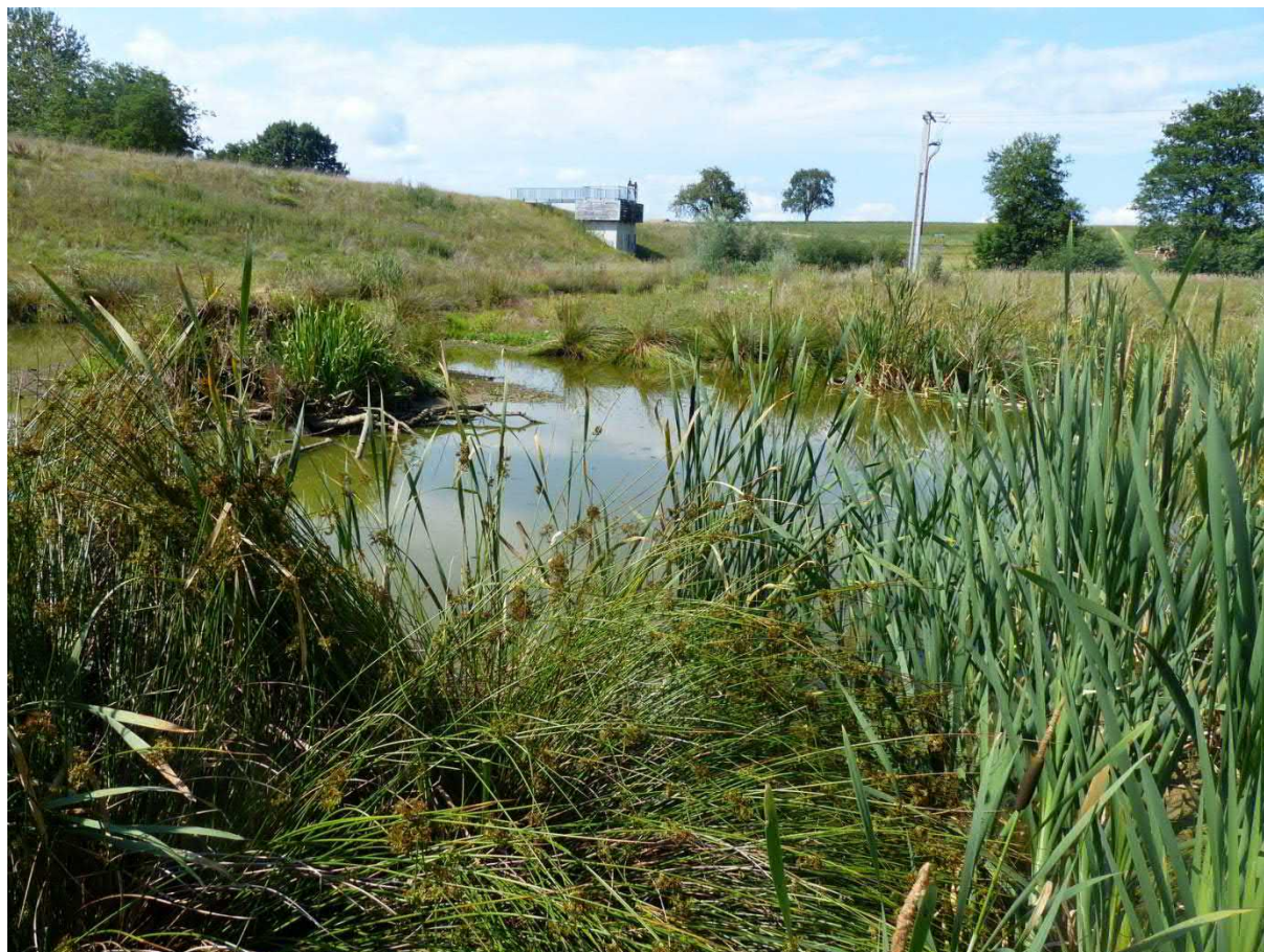
Zone de ralentissement dynamique des crues de Bisel (Photo CD68)
