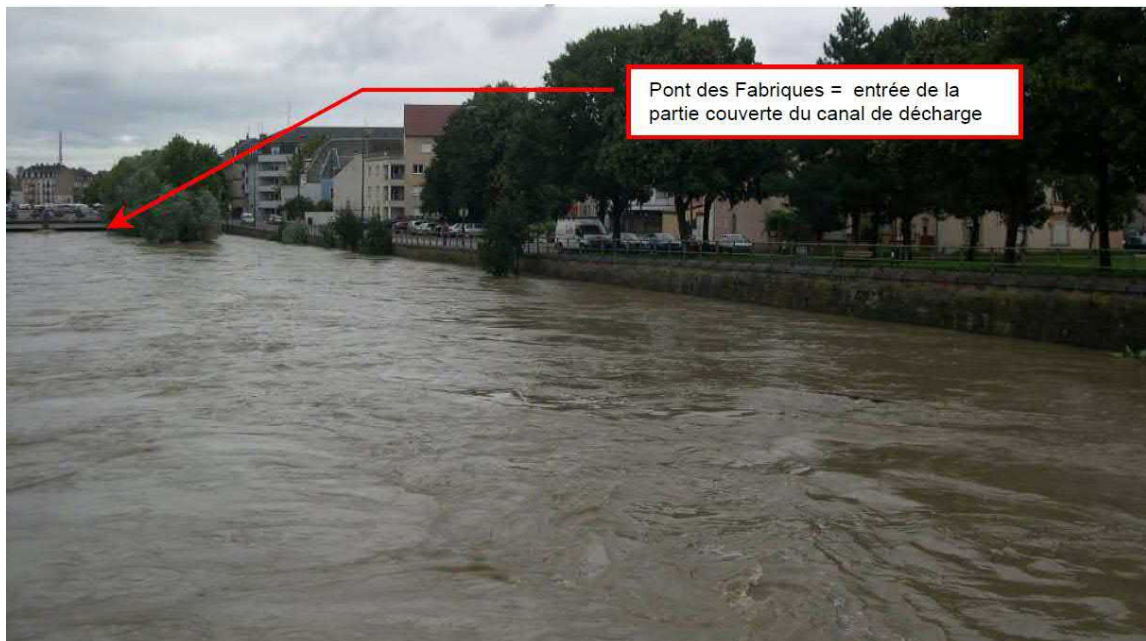
Vue du canal de décharge de l'III à l'amont du pont des Fabriques lors de la crue d'août 2007
