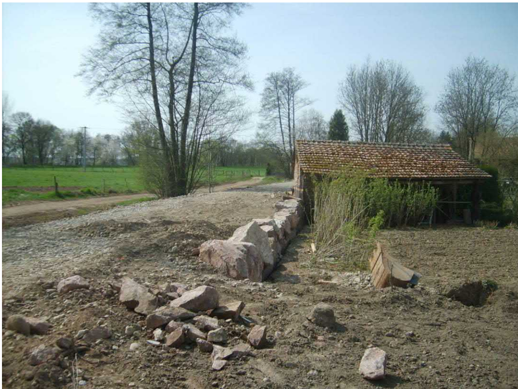
Confortement d'une digue de la Doller à Reinique en 2014 (Photo CD68)
