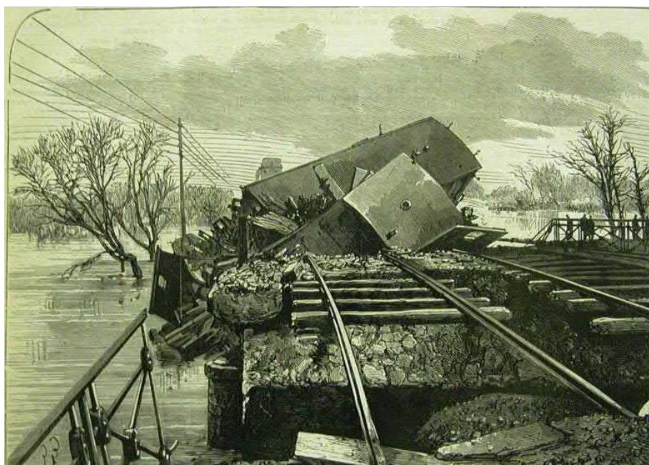
Accident ferroviaire à Lutterbach à la suite de la rupture d'un pont sur la Doller en crue
