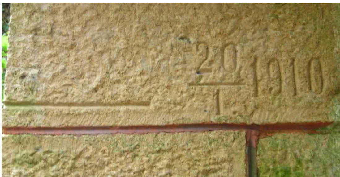
Repère de crue sur le pont de la Largue à Seppois-le-Haut (Photo L. With)
