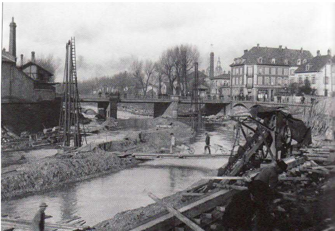
Travaux de régularisation du canal de décharge de l'III – Pont de la rue A. Briand (1905-1908) (Source : BSIM)
