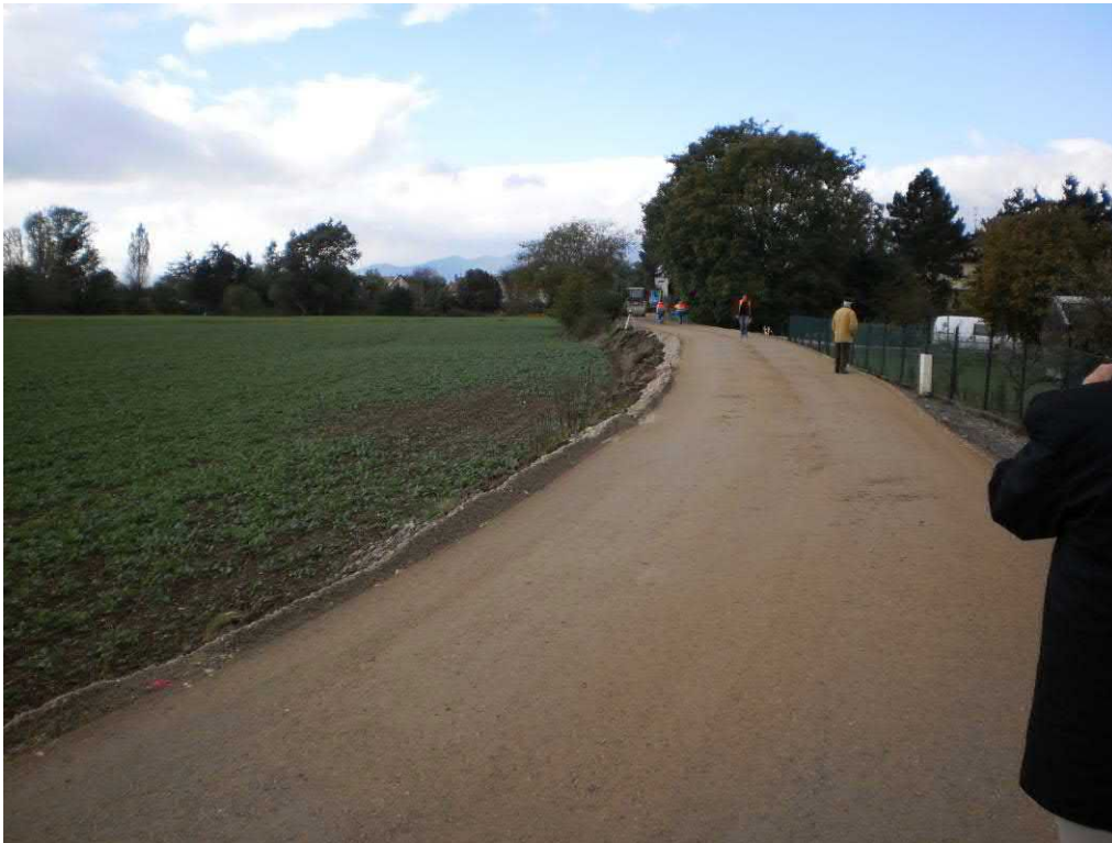
Renforcement d'une digue de l'III à Ruelisheim en octobre 2010 (Photo CD68)
