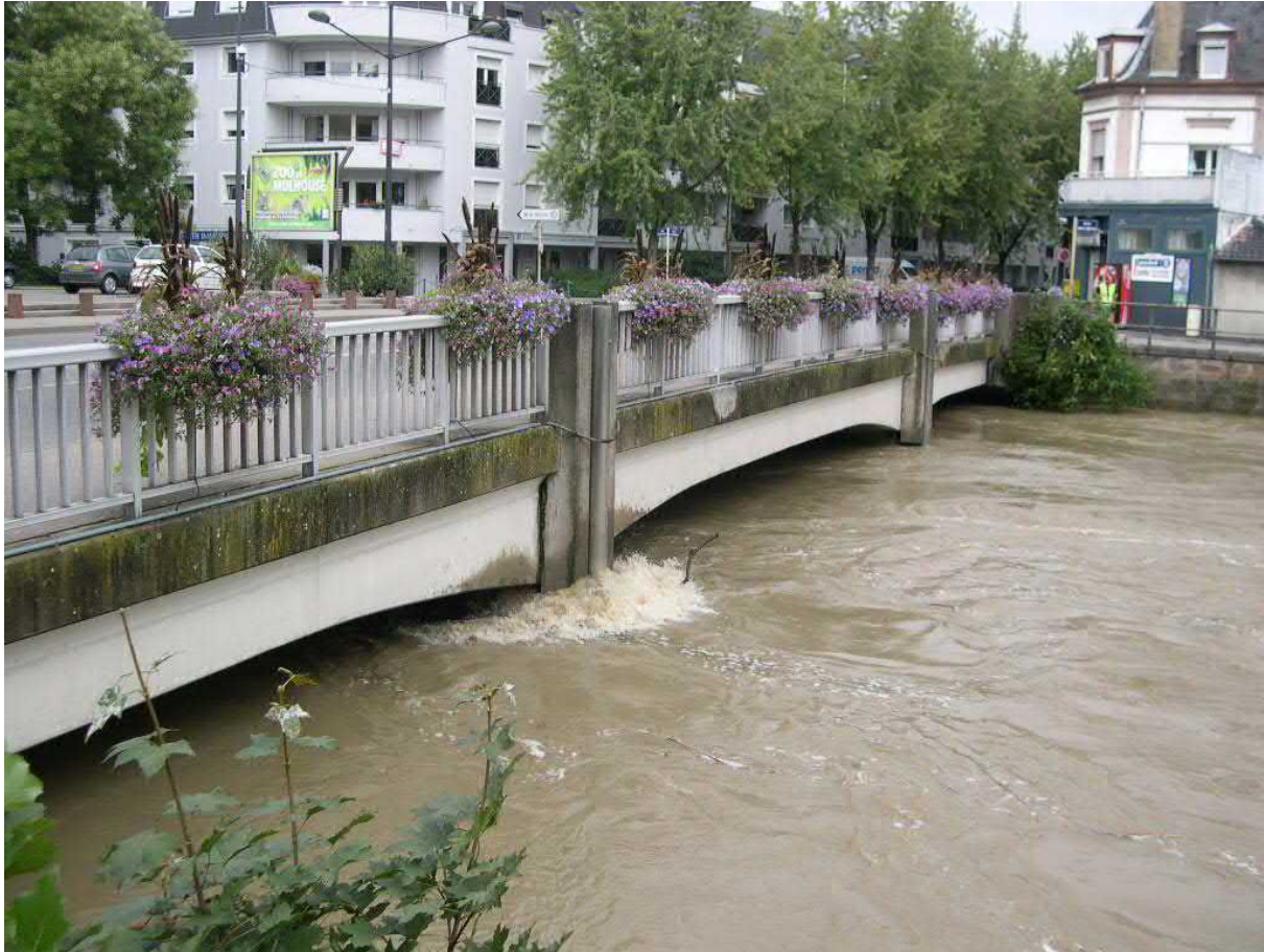
Le canal de décharge des eaux de l'Ill à Mulhouse au pont de la rue des Fabriques (début de la partie couverte) lors de la crue du 9 août 2007 (Photo CD68)
