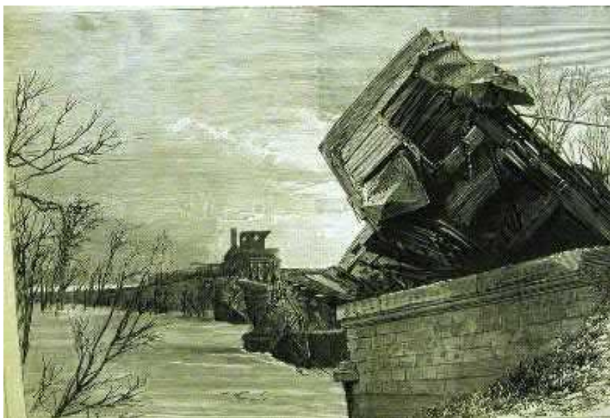
Accident ferroviaire à Lutterbach à la suite de la rupture d'un pont sur la Doller en crue
